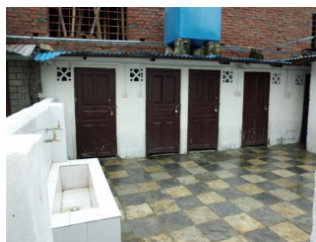
Renovatie Toiletten Pokhara Nepal
